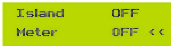
Pic 7.18 Meter switch
